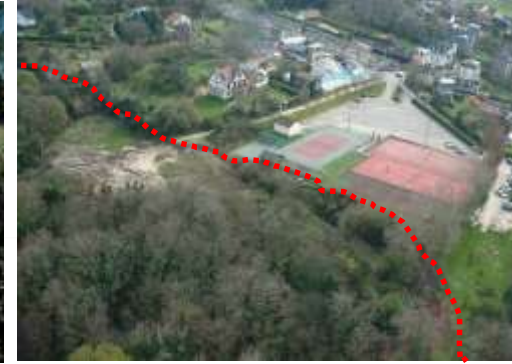
Tennis endommagés (Villerville) (cliché : Diren, 2001 & O. Maquaire, 2001)
