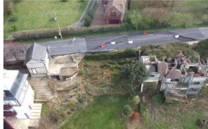
Affaissement au droit villa Trescartes (détruite en 1982) au cirque des Graves (Villerville) (cliché : Diren, 2001)
