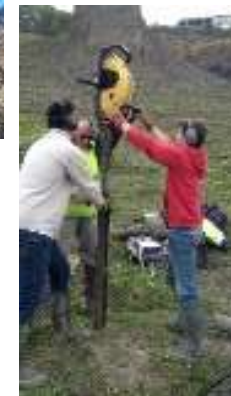
Sondage vibro-percuteur à gouges
